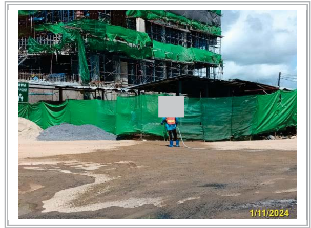
รูปที่ 3-8 ฉีดพรมน้ำบริเวณพื้นที่ก่อสร้าง
