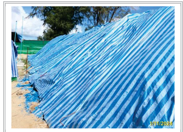
รูปที่ 3-16 กองวัสดุที่ปิดด้วยผ้าใบ
